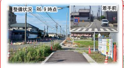
市道橋詰見越線について、歩道の整備、車道の拡幅を行った。【道路幅員 6.0m → 16.0m】
